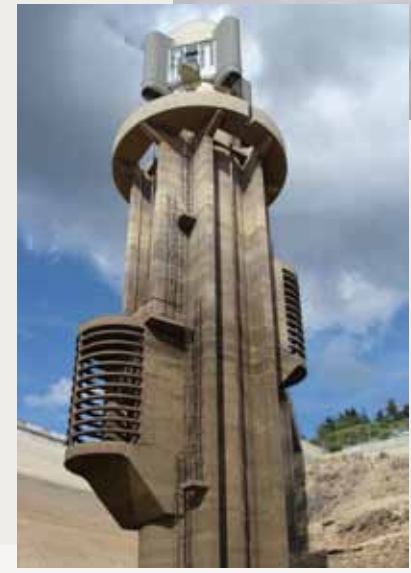
Tour de prise d'eau
